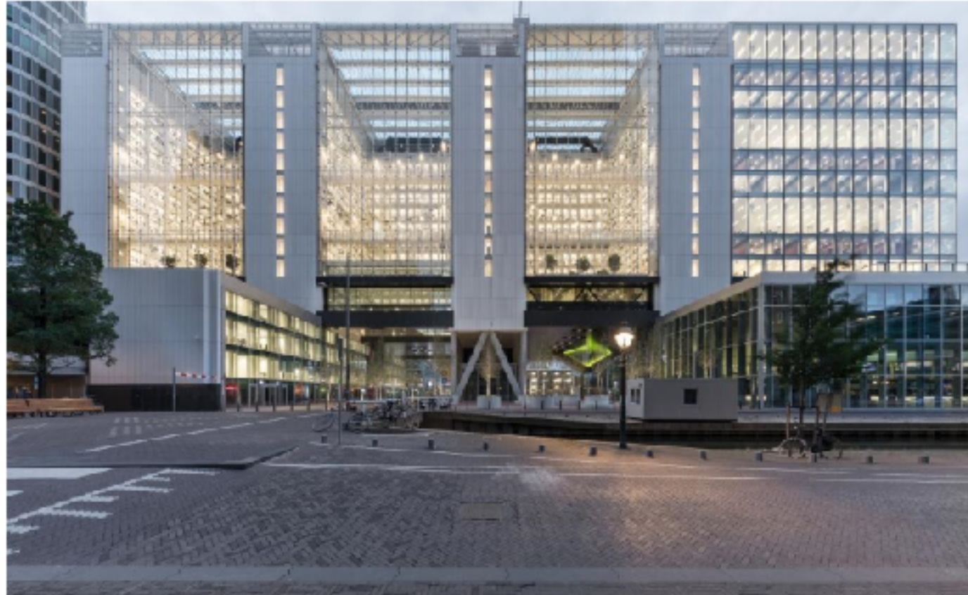
Rijnsraat 8 in Den Haag. Photo: ArchDaily
